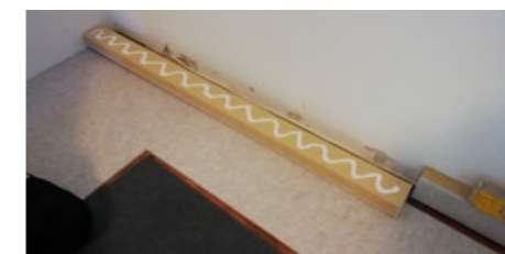
Sockel: Kleber anbringen, andrücken, im Wasser ausrichten und unterlegen, damit sich der Sockel nicht mehr verschiebt.
