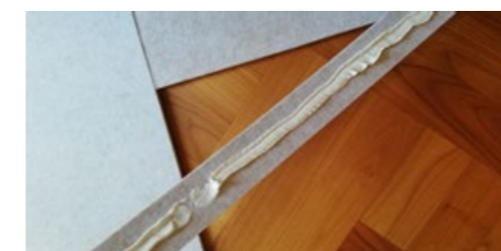
Falls Randleisten: Kleber anbringen und aufdrücken.
