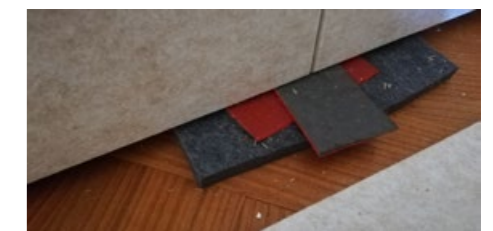
Sockel: Kleber anbringen, andrücken, im Wasser ausrichten und unterlegen, damit sich der Sockel nicht mehr verschiebt.
