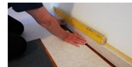
Sockel: Kleber anbringen, andrücken, im Wasser ausrichten und unterlegen, damit sich der Sockel nicht mehr verschiebt.
